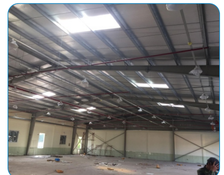
NHÀ MÁY MÁY TẠİ KCN NGANG TP. ĐÔNG HÀ - QUẢNG TỊ
